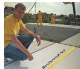
Арматура укладывается посередине заливочного паза
